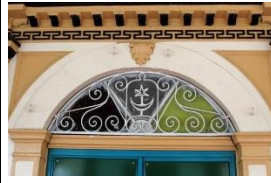
Menderes, Gölçükler Mahallesi Camii
