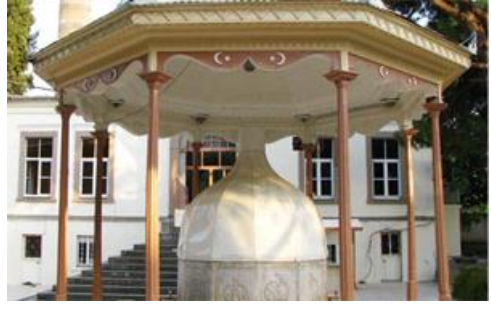
Bergama, Yeni Camii
