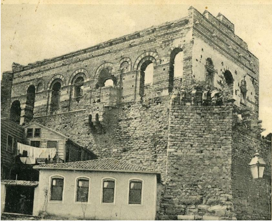
İstanbul-Tekfursarayı Beşir Gâzi Türbesi ve Sa'di Tekkesi
