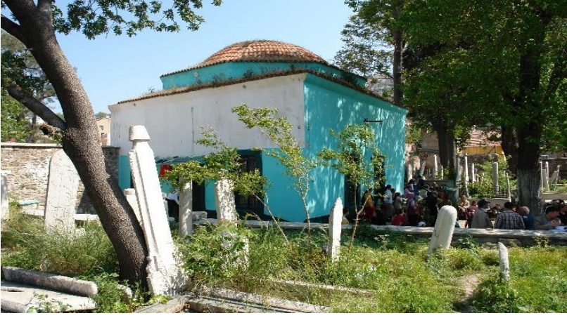
Restorasyon Öncesi Türbe
