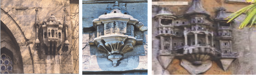
Görsel 2. (sol) Bâyezid'de Seyyid Haşan Paşa Medresesi'nin cami biçimindeki kuş evi. (orta) Üsküdar Selimiye Camii'ndeki kuş evi. (sağ) Topkapı Sarayı Darphane-i Amire binasındaki kuş evi.
