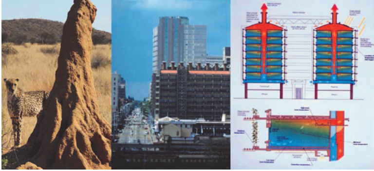
Şekil 3: Termit kulelerinin bacası kısmından esinlenerek yapılan yapı (Cuce ve ark., 2017, s. 4).
