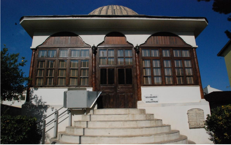
Fotoğraf 1: Necippaşa Kütüphanesi'nin güney cephesinden dış görünümü
